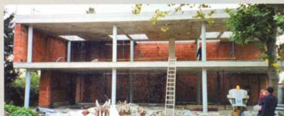
Le gros œuvre terminé
